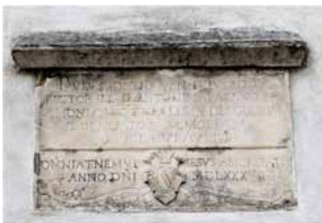
Fig. 11 - Iscrizione collocata sulla parete esterna del presbiterio (1582)
