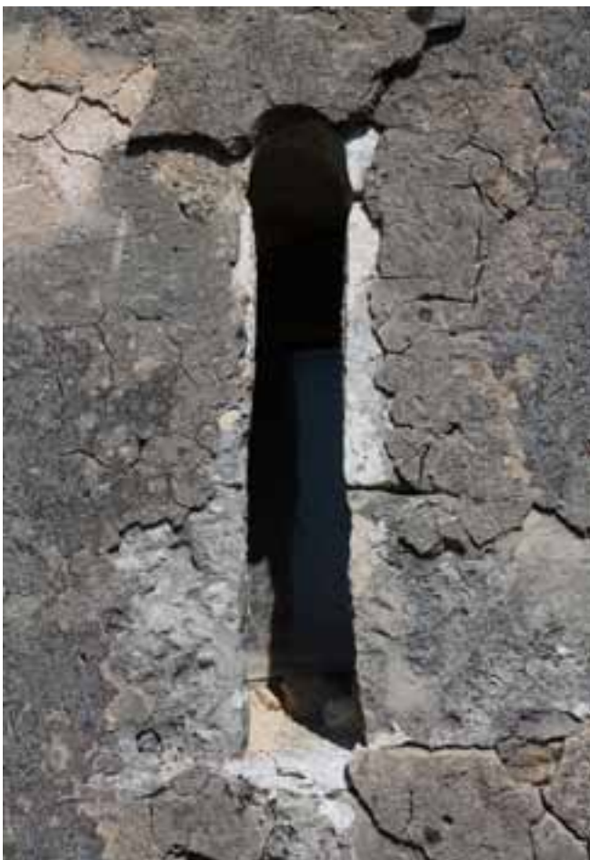
Fig. 30 Finestra a ferritoia con piccolo arco a tutto sesto che guardava che stava nell'asse centrale dell'abside.
