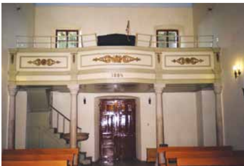
Foto 36. Particolare della cantoria all'interno della chiesa di S. Martino prima della ristrutturazione (foto Gianfranco Abrami)
