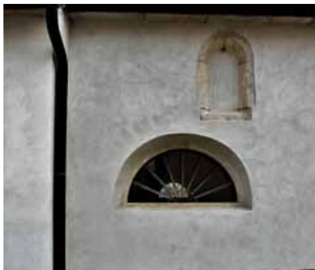
Fig. 9 - Finestra murata dell'impianto originale anni '60 del XVI sec.
