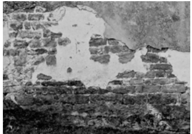
Fig. 31 - Particolare della tecnica muraria sulla parete nord.
