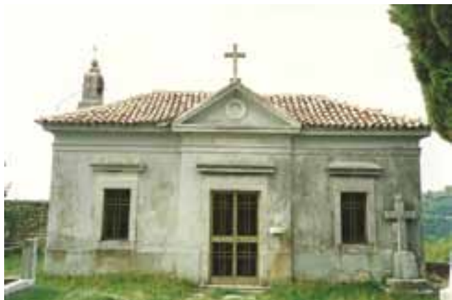
Chiesa di San Rocco a Momiano.
